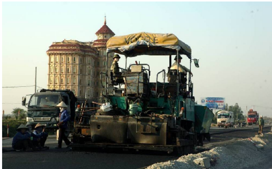
Thi công đường giao thông máy rải nhựa
