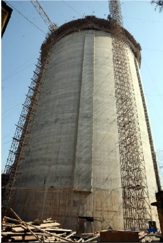
Thi công silô kết hợp nâng mái và kéo căng nhà máy xi măng Bim Sơn
