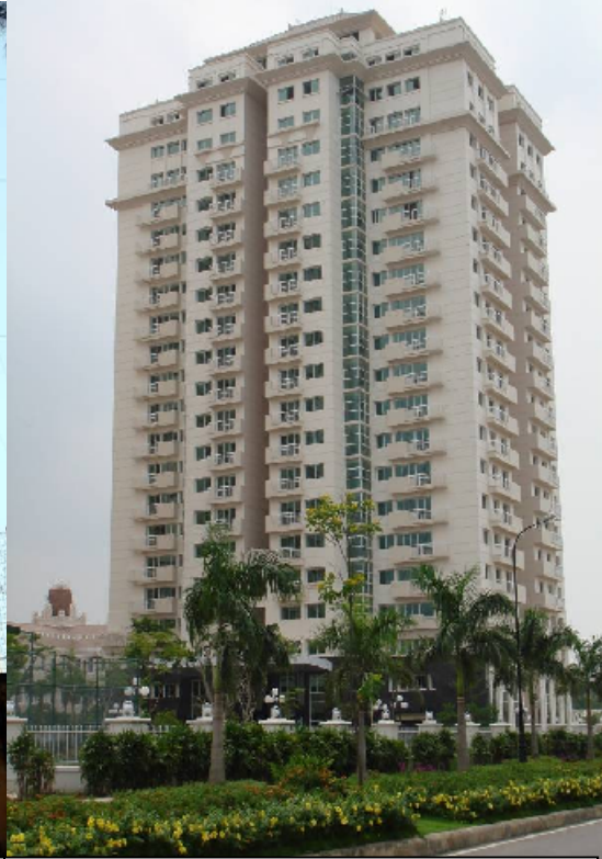
Thi công xây dựng chung cư cao cấp và văn phòng cao tầng
